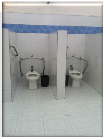
Baños y duchas
